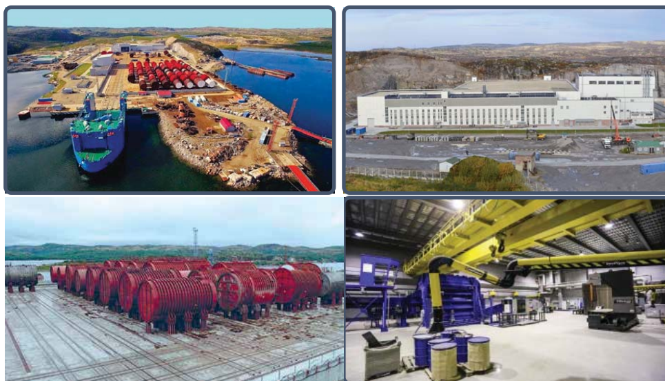
Рис. 6. Созданные сооружения в Сайда-губе: пункт длительного хранения радиоактивных отсеков (ПДХ РО, слева) и Центр кондиционирования и длительного хранения РАО (РЦКДХ РАО, справа)
