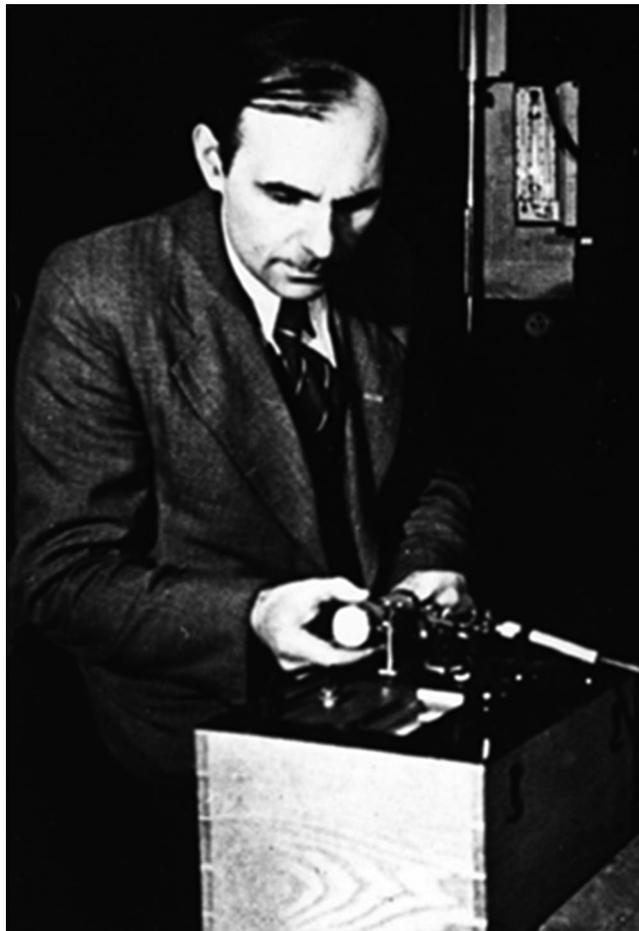
П. Г. Романков за наладкой газоанализатора для автоматической сигнализации о применении отравляющих веществ (военные годы).
