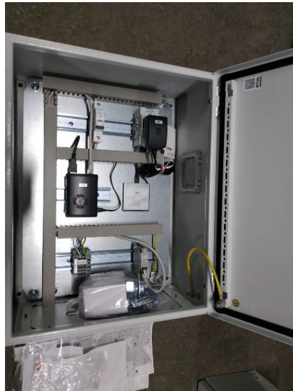
Рис. 6. Штатный вариант расположения диагностического оборудования.
