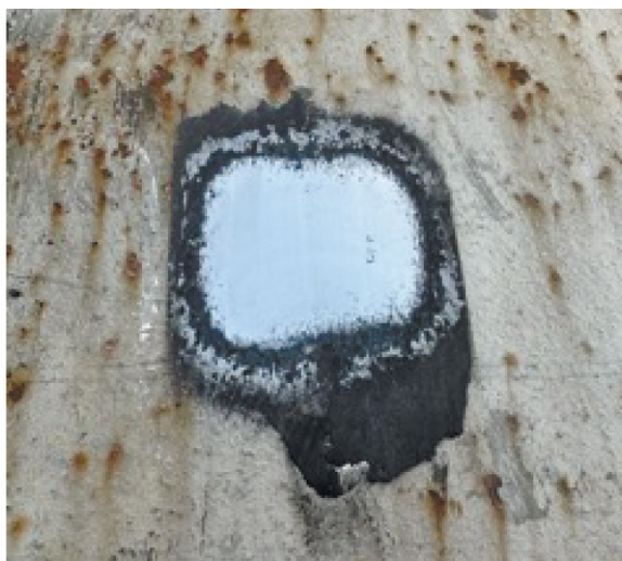
Рис. 3. Общий вид подготавливаемой площадки на поверхности трубы Ду 830 мм.
