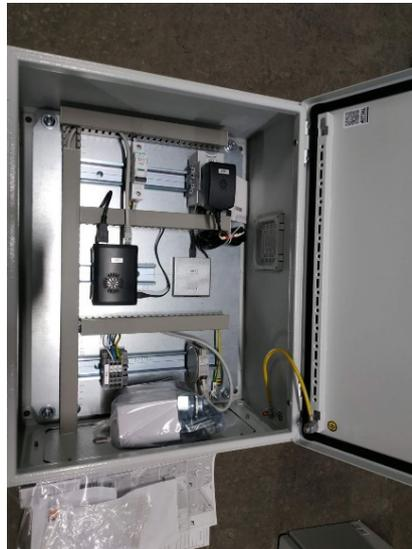
Рис. 6. Штатный вариант расположения диагностического оборудования.
