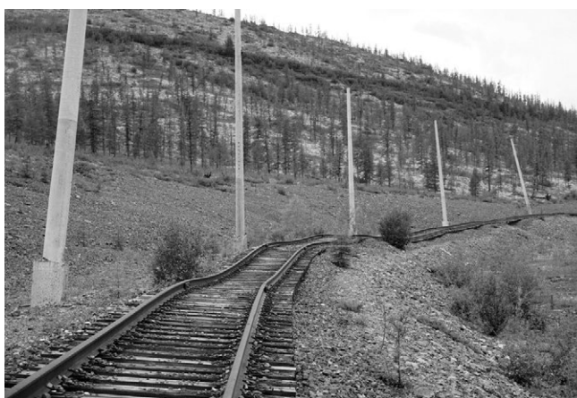
Рис. 15. Волнообразные просадки участка железнодорожной ветки Новая Чара – Чина (68-й километр дороги), вызванные термокарстовым процессом (фото А. Кулакова).
