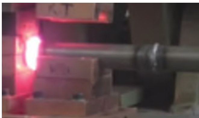
Рис. 1. Сварка труб на установке МСО-201Н
