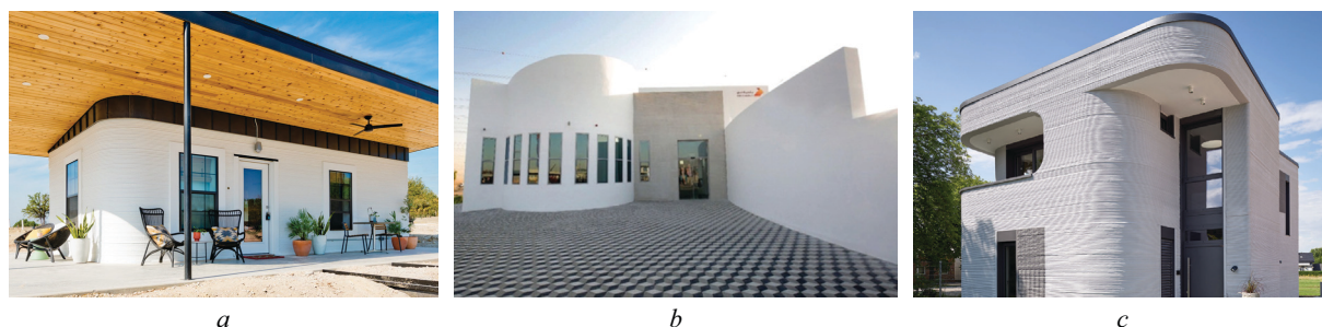
Рис. 10. Примеры строительных объектов, напечатанных на 3D-принтере компаний Icon Corp. (a); Apis Cor (b) и Cobod Int. (c) [140–142]
