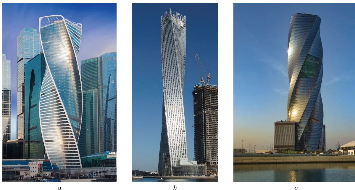
Рис. 1. Высотные здания с закручивающейся формообразующей: a — Башня Эволюции (Москва, Россия); b — Cayan Tower (Дубай, ОАЭ); c — United Tower (Манама, Бахрейн)
