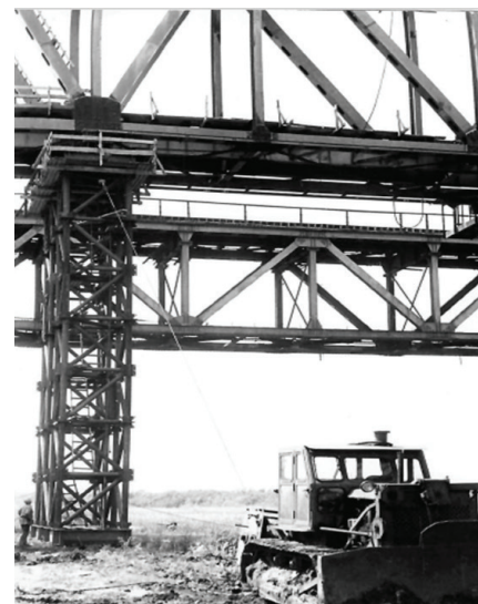
Рис. 2. Общий вид вспомогательной опоры под нагрузкой Fig. 2. General view of the auxiliary support under load
