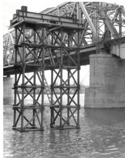
Рис. 1. Общий вид вспомогательной опоры до нагружения Fig. 1. General view of the auxiliary support before loading
