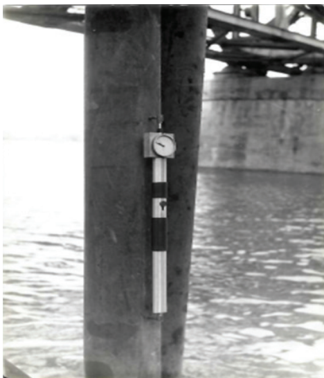
Рис. 4. Измерение относительных деформаций элементов опоры деформометром с базой 505 мм
