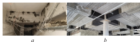
Рис. 6. Несущие конструкции буддийского храма: a — до усиления; b — после усиления
