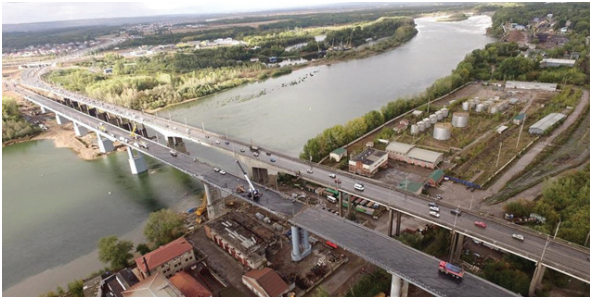
Рис. 2. Оснащение Затонского моста системой мониторинга Fig. 2. Equipping the Zatonsky Bridge with a monitoring system
