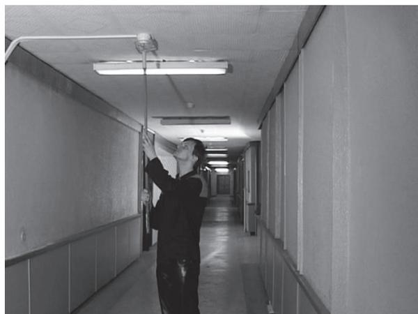
Рис. 2. Процесс проверки дымового извещателя
