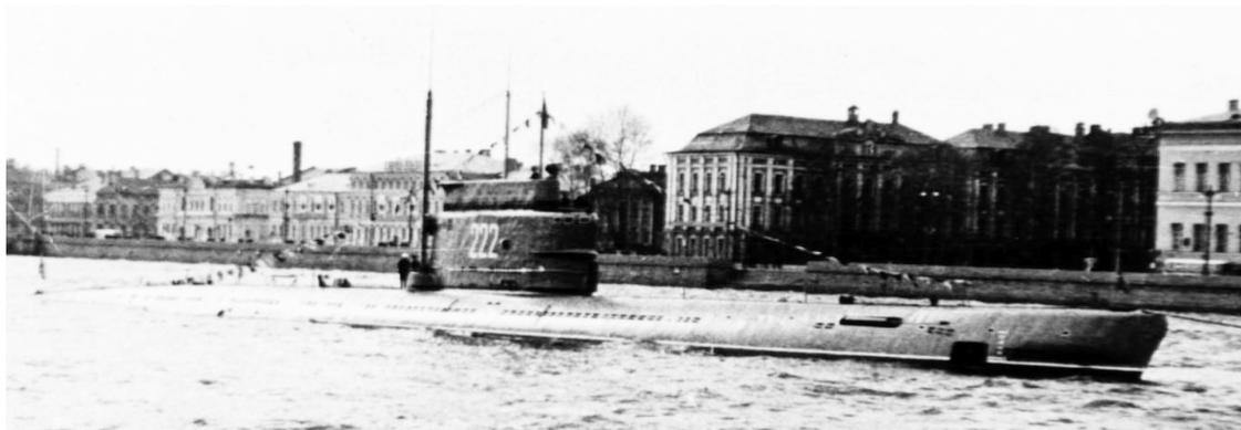
Рис. 6. Подводная лодка «Б-61» проекта 611, переоборудованная в 1962–1963 гг. под испытания ПГД. Из фондов СПб ГБУК «МИПСР им. А.И. Маринеско»
