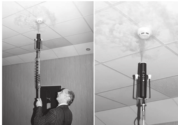
Рис. 13. Проверка дымовых пожарных извещателей комплектом КТП-1
