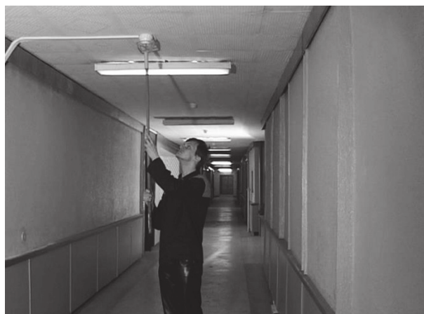
Рис. 2. Процесс проверки дымового извещателя
