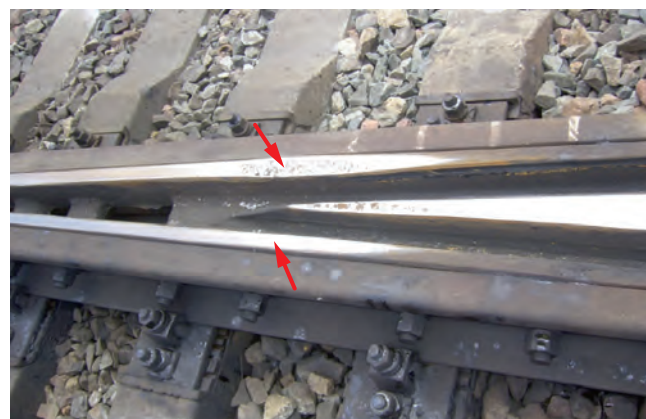
Рис. 2. Сплывы и выкрашивание металла на рабочих поверхностях крестовин типа Р65 из-за воздействия колес с повышенной нагрузкой
