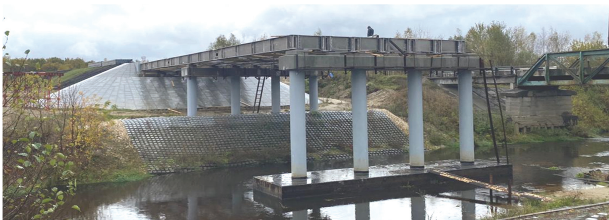
Рис. 17. Установка пролетного строения на железобетонные опоры
