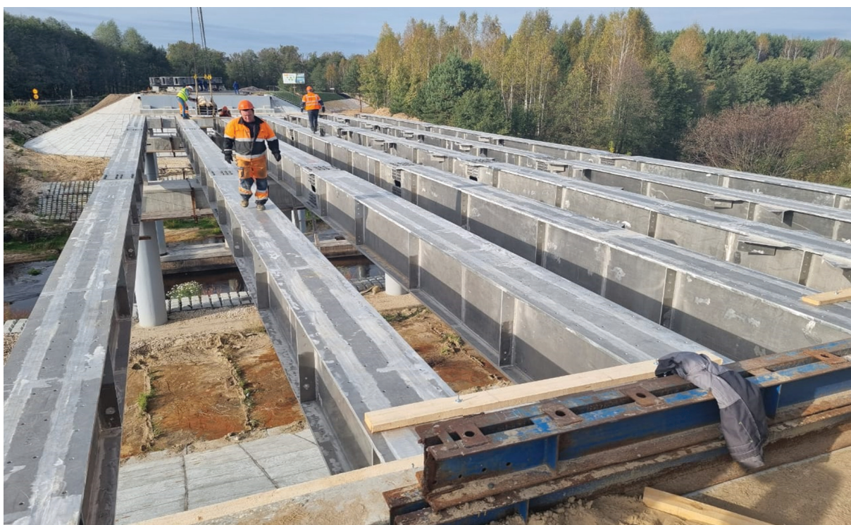
Рис. 18. Установленные несущие балки пролетного строения
