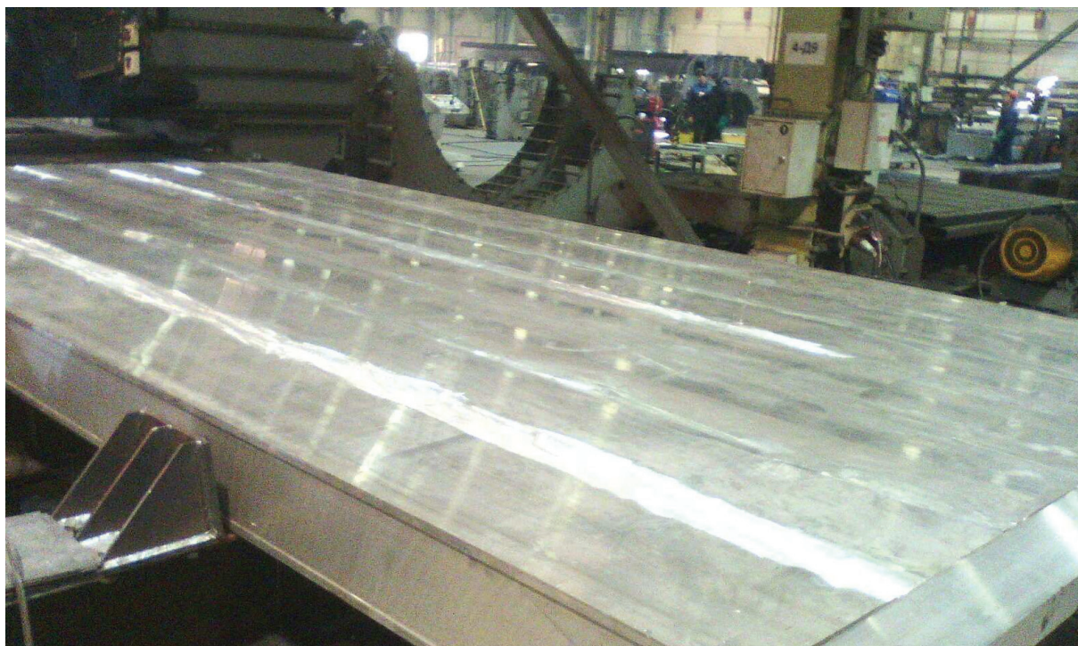
Рис. 9. Сварка на стенде методом трения с перемешиванием ортотропной плиты
