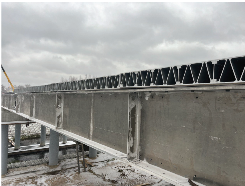
Рис. 19. Установка ортотропных плит на несущие балки пролетного строения
