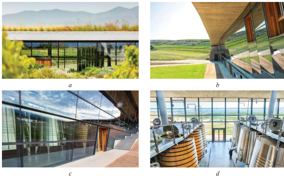
Рис. 1. Архитектурные решения винодельни Beronia, Испания (архитекторы IDOM): a — часть фасада; b — остекление фасада; c — экстерьер; d — интерьер 1
