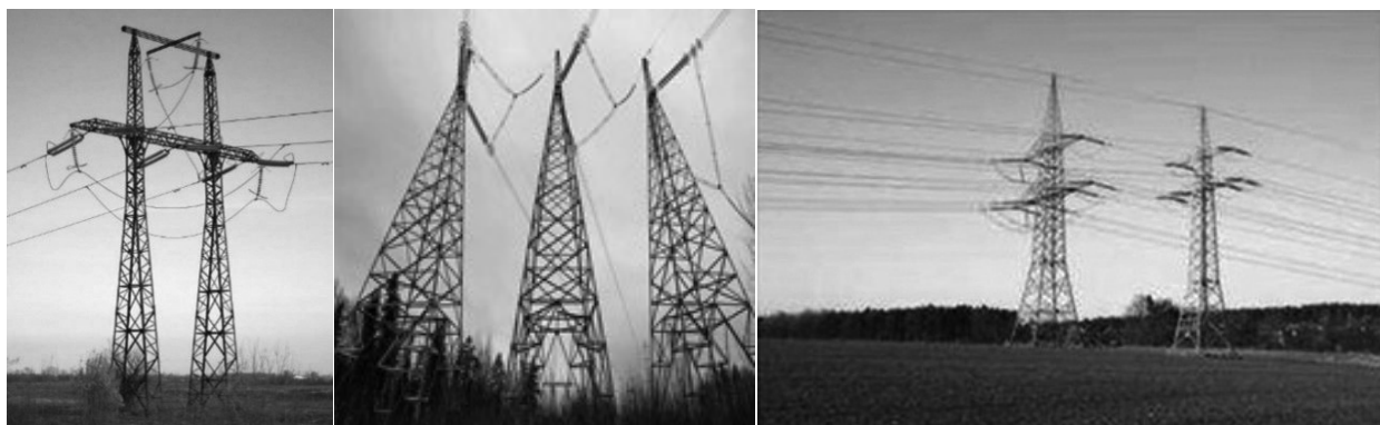
Рис. 1. Виды опор воздушных линий электропередач
