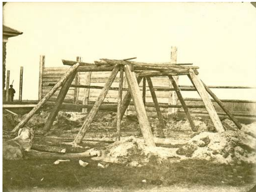
Рисунок 2. Каркас усеченно-пирамидальной полуземлянки из с. Ларьякское на р. Вах.
