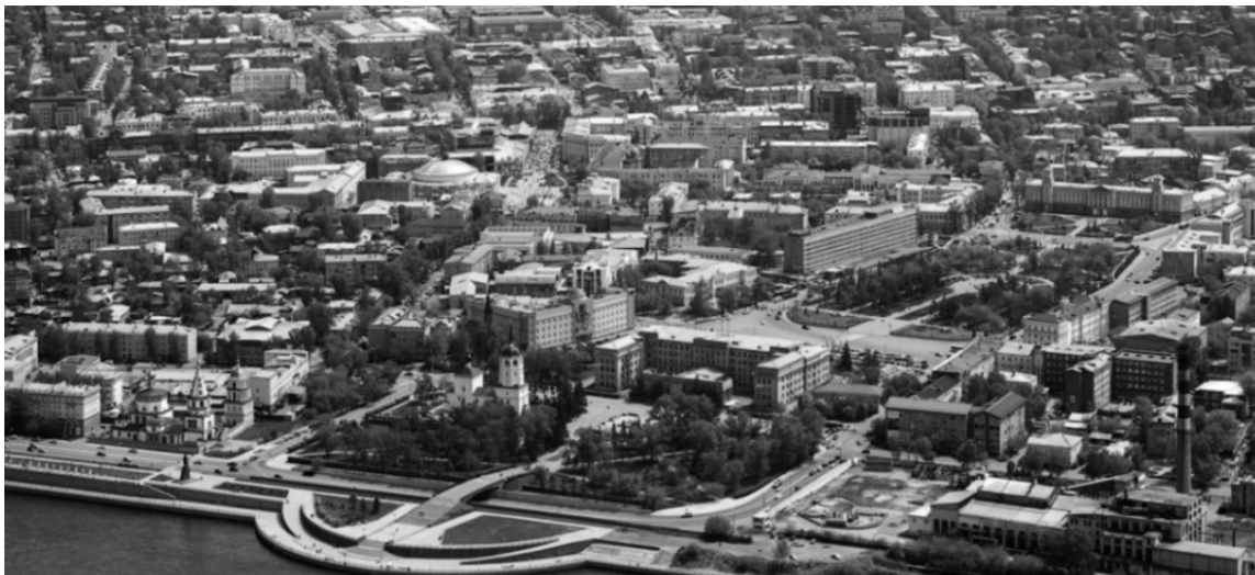
Рис. 5. Вид ЦЭСовской набережной. Сквер на переднем плане – место острога со Спасской церковью, 1710 г. Справа – тепловая станция 1920-х гг. – ЦЭС
