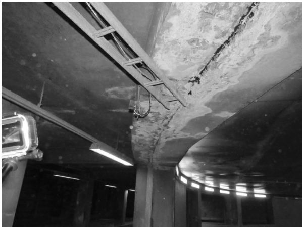
Рис. 6. Следы процесса выщелачивания с разрушением защитного слоя и оголением поперечного армирования по нижней грани балок плиты покрытия на втором этаже в зоне сопряжения блоков здания (температурный деформационный шов) Fig. 6. Traces of the leaching process with destruction of the protective layer and exposure of transverse reinforcement along the lower edge of the beams of the coating plate on the second floor in the interface area of the building blocks (temperature deformation joint)
