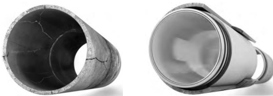
Рис. 2. Результат восстановления трубопровода
