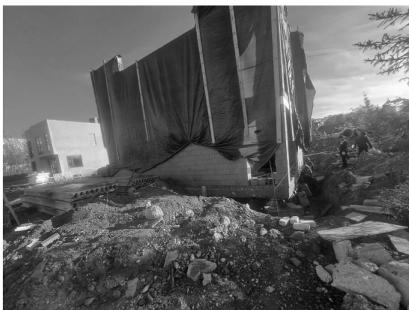
Рис. 18. Работы по исправлению крена индивидуального жилого дома по ул. Ольховской Fig. 18. Work to correct the roll of an individual residential building on the street. Olkhovskaya
