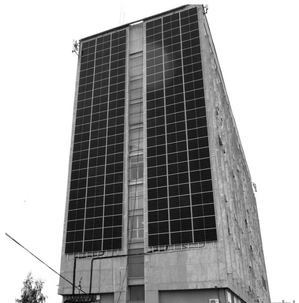
Рис. 3. Фасад одного из корпусов Уральского федерального университета в Екатеринбурге [9]
