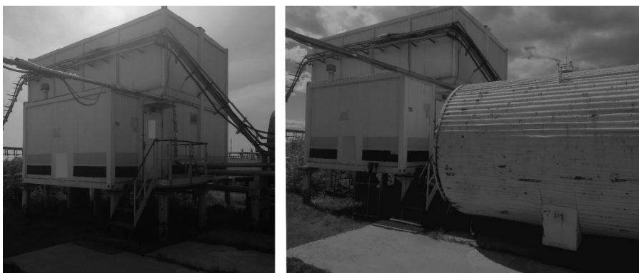
Рис. 2. Станция КСкомплект-100 до и после начала модернизации Fig. 2. KSkomplekt-100 station before and after the start of modernization
