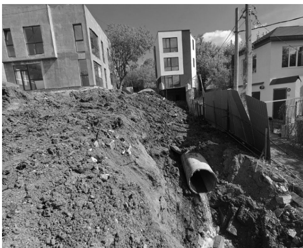
Рис. 19. Засыпка оврага на примере устройства строительной площадки на ул. Ольховской Fig. 19. Gully backfilling using construction site as an example on the street Olkhovskaya
