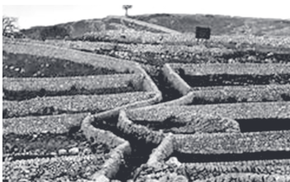
Рис. 2. Каменные изгороди по методу сухой кладки в окрестностях Ното 3
