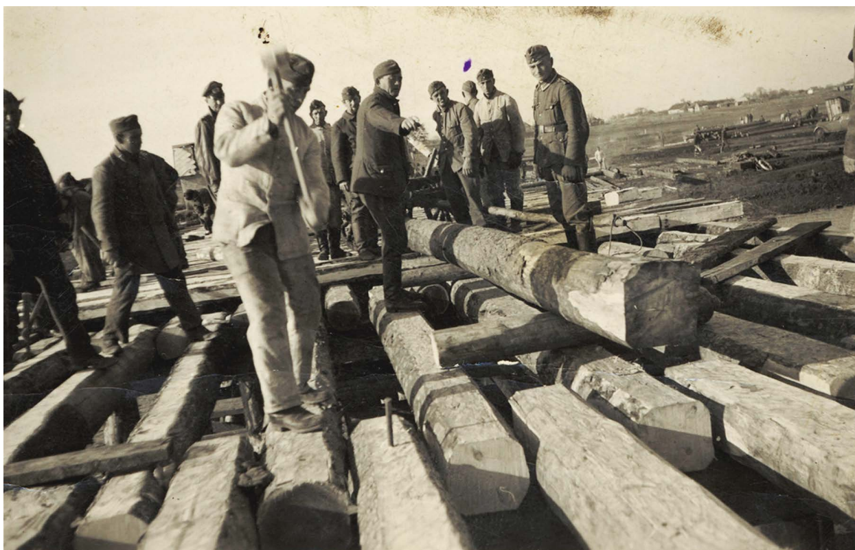
Ил. 4. Советские военнопленные на принудительных работах по строительству железной дороги (1941–1942 гг.) (источник: United States Holocaust Memorial Museum. Photograph Number: 16755)
