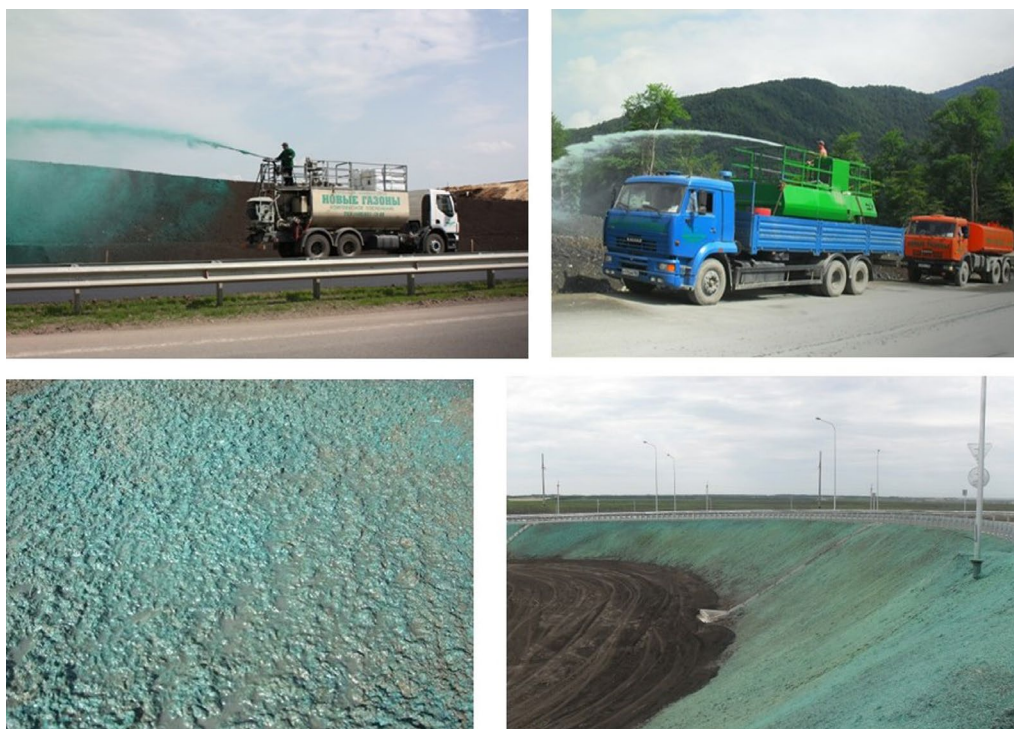
Р и с. 1. Фото гидропосева газонной травы
