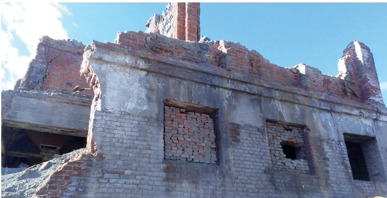
Рис. 3. Цех рафинации мышьяка с кулерами (2016 г.) Fig. 3. Arsenic refining plant with coolers (2016)
