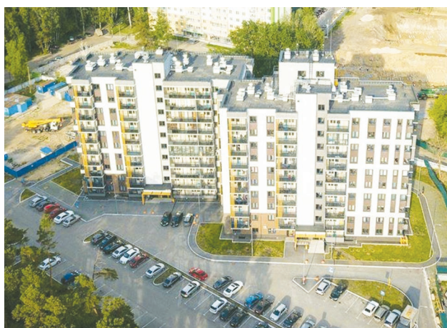
Рис. 6. Строительство ЖК «Финский залив» на территории бывшего Жабынского завода
